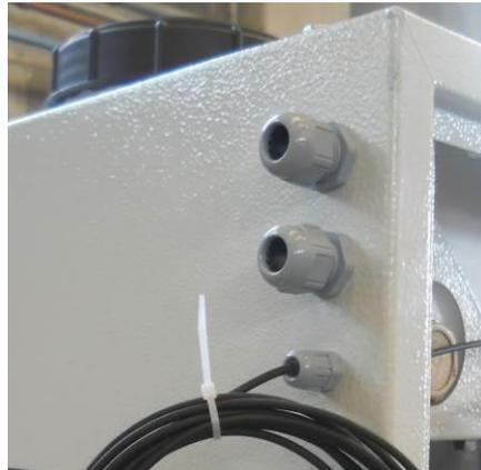
Abbildung 5 – Platte für Stromanschlüsse
