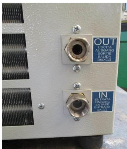
Abbildung 3 – Platte für Hydraulikanschlüsse
