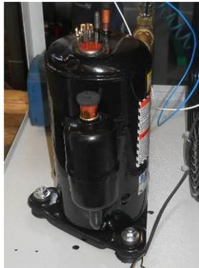
Abbildung 17 – Kompressor Platzierung für CCE 6101 – 6201 – 6301
